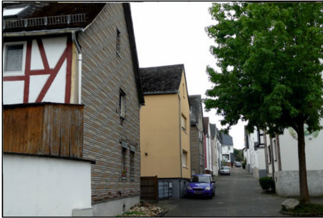
Bauflucht und Sanierungsbedarf (Oberdorfstraße Elz)
