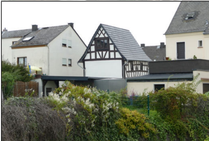
„Innenansicht“ (Rückseite Rathausstraße)
