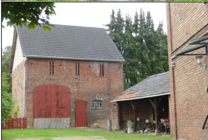
Scheune Hadamarer Straße
