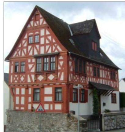
Abb. 3 Bausche Haus, Pfortenstr.19
